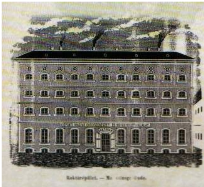
4. ábra, A Wagner alapította gyár épülete
