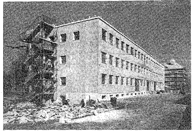
1. ábra Az épülő színház az üzemi épület felől tekintve
