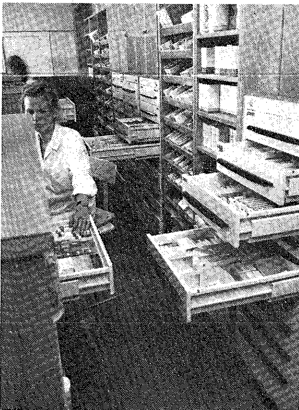
1. ábra. Officinai kiadó munkahely az állványba és az asztalra beépített teleszkópos-fiókos szekrényekkel
