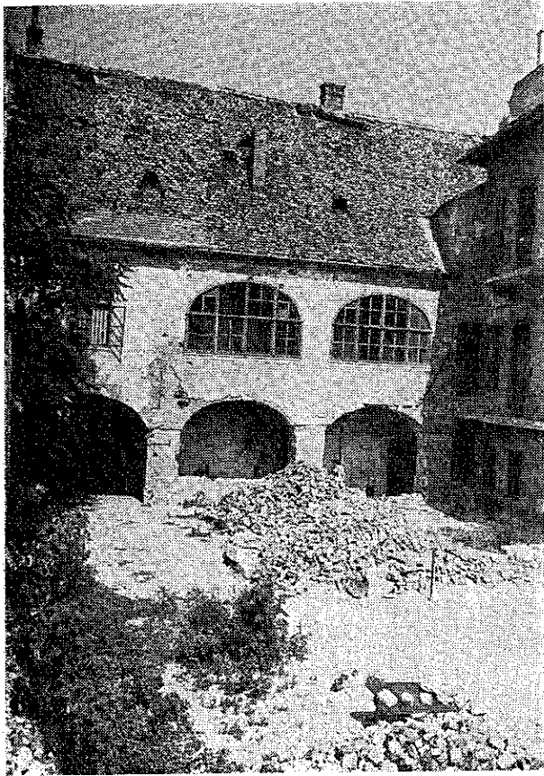
2. ábra. Az épület udvari, emeleti árkádyilásos homlokzata a XVIII. sz.-ből
