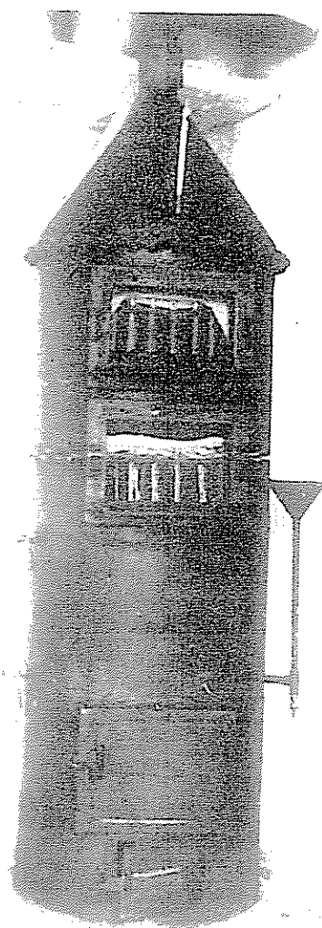
3. ábra. Korabeli autokláv, amelyben a Calcifor készült
